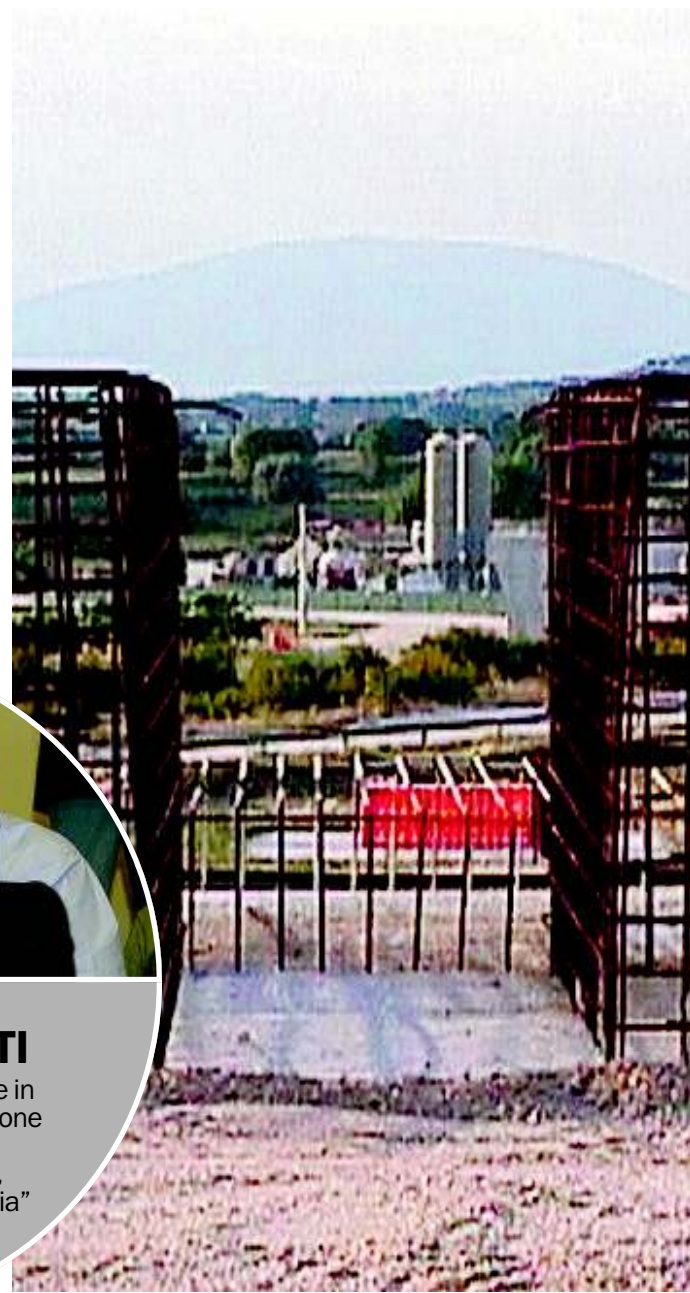
Un cantiere stradale
